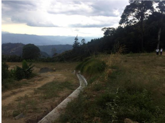
Panoramica de una de las cuentas vehiculares construida que deben replicarse en toda la extension del lote.
