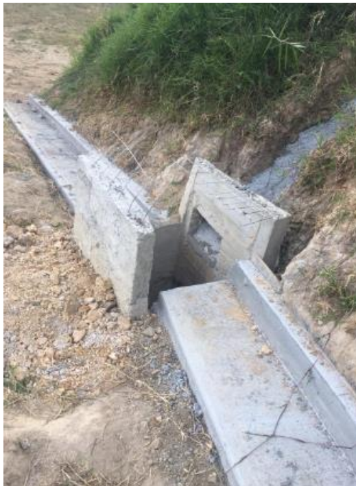
Construccion de cajas de inspeccion para captar las aguas de las cuentas.
