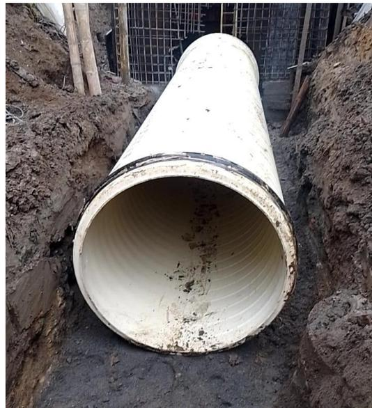
Instalación tubería de 48" desde aliviadero 3 a cámara N02
