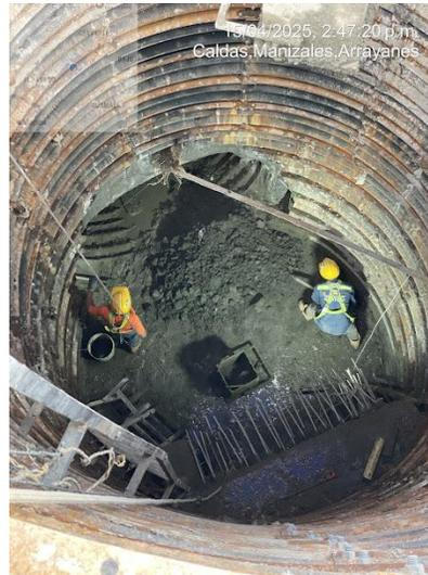
Retiro de material de excavación desde el túnel
