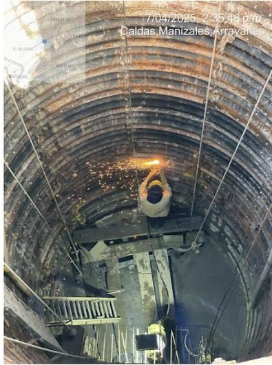
Corte con plasma en lámina linner en pozo C-3A
