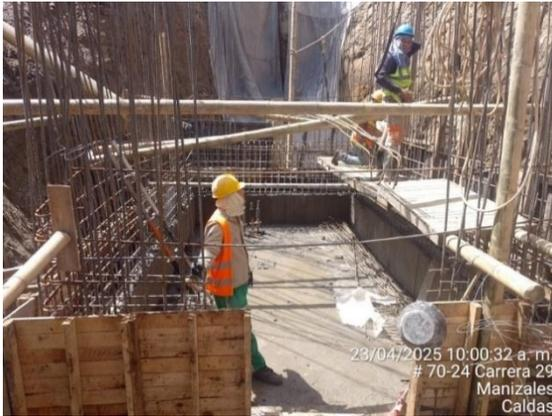
Losa piso y muros H=0.65 m aliviadero
