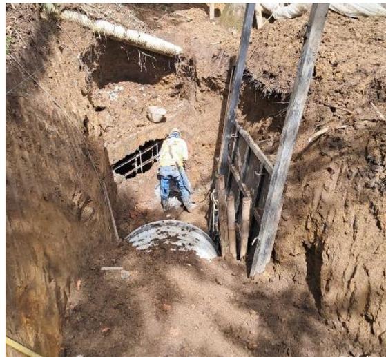
Instalación tubería de 48" desde cámara A03-06 a cámara N11
