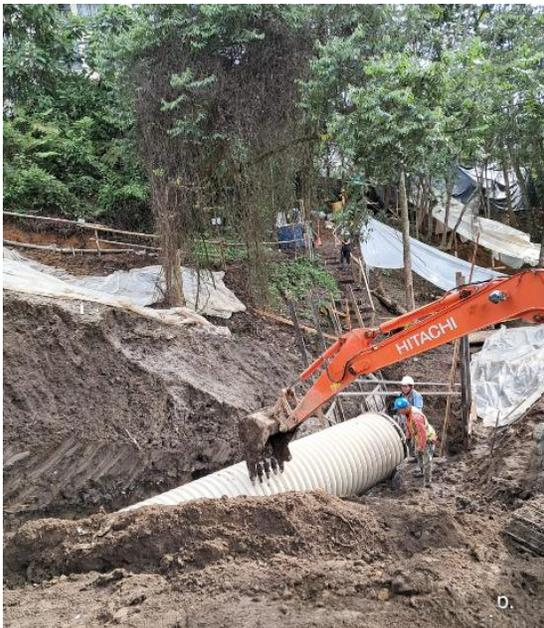
Instalación tubería de 48" desde cámara N02 a cámara A03-06
