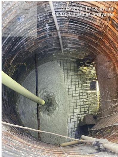
Vaciado de concreto para losa de piso en pozo C-3A
