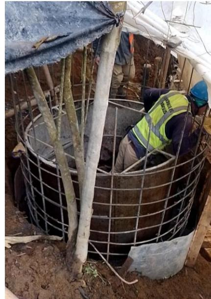
Instalación acero de refuerzo cámara
