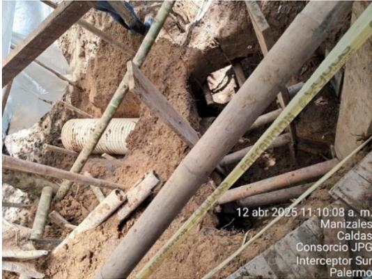
Instalación tubería 24" entre cámaras A02-04 y N10
