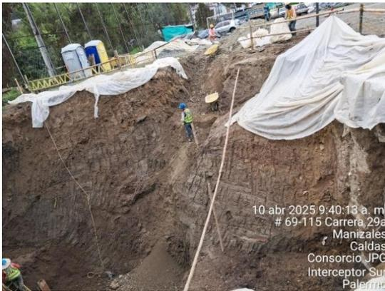
Excavación aliviadero 3 sector cancha La Italia perfilado taludes
