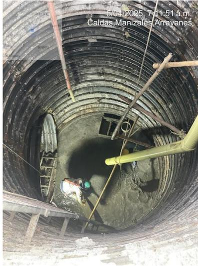
Vaciado de concreto para tapón de fondo en cámara C-2A
