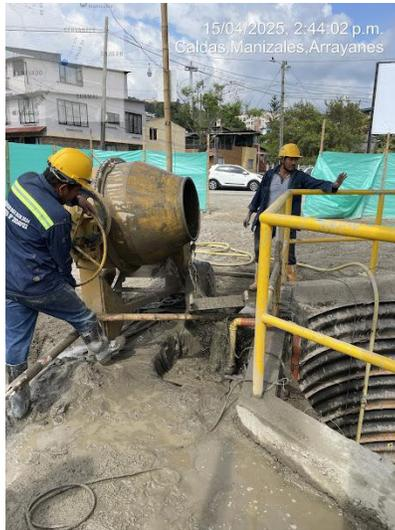
Inyección de mortero con motobomba
