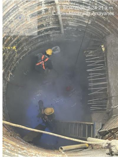
Demolición de concreto existente en pozo C-3A
