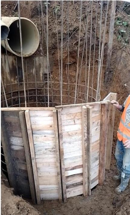
Instalación acero de refuerzo cámara N10
