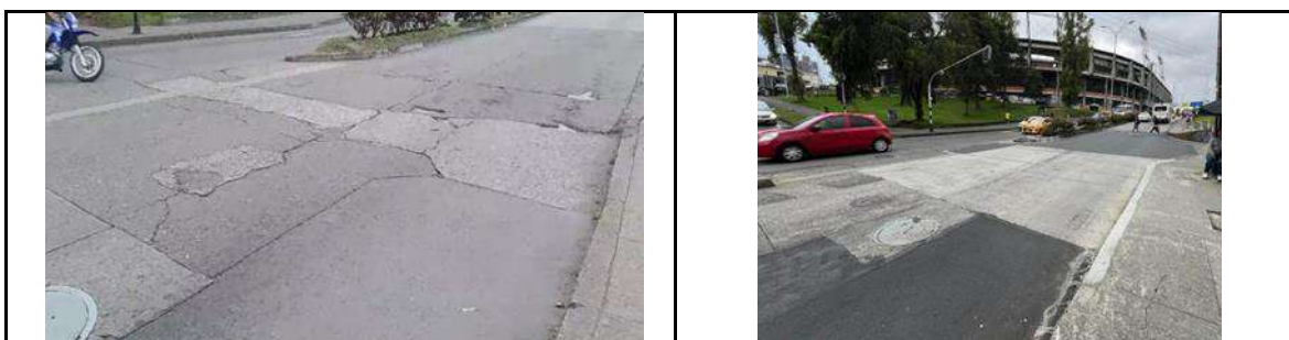
Contrato 2406280841 - Mantenimiento y rehabilitación de vías urbanas, mediante la reparación, construcción de pavimentos y peatonales sobre la avenida Kevin Ángel de la ciudad de Manizales
