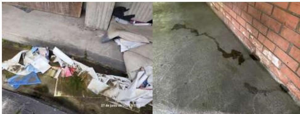
*Imagen: Der: Mal manejo de basura en el foso. Izq: Filtración del baño al pasillo.*
