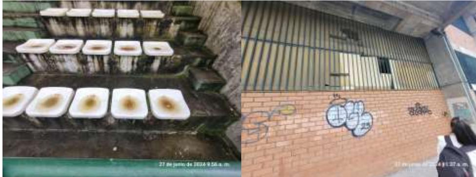
*Imagen: Der: Humedad en las primeras filas. Izq: Deterioro en la Fachada*
