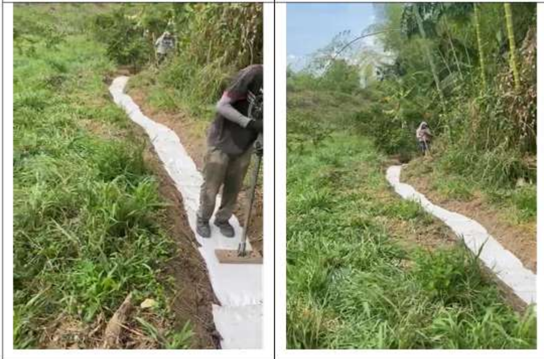
Fotografías 1 a 6. Ejecución de obras continuación canal predio Carlos Mario Gutierrez
