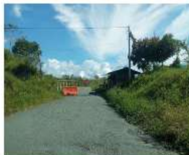
Fotografía 3-2 Campamento PR 16+000 Fuente: Concesión Pacifico Tres (2023)
