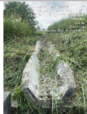
Fotografía 1 y 2. Cuneta paralela al predio Alejandría
