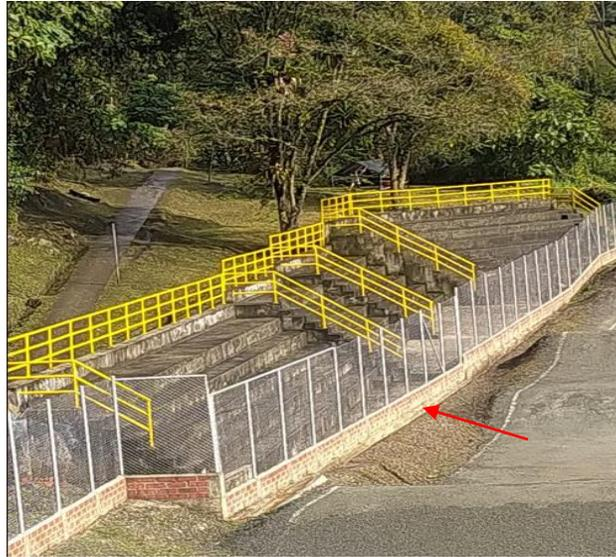
Imagen (4) Zona de graderías actualmente con malla eslabonada, retiro de la pista y losas de concreto ejecutadas
