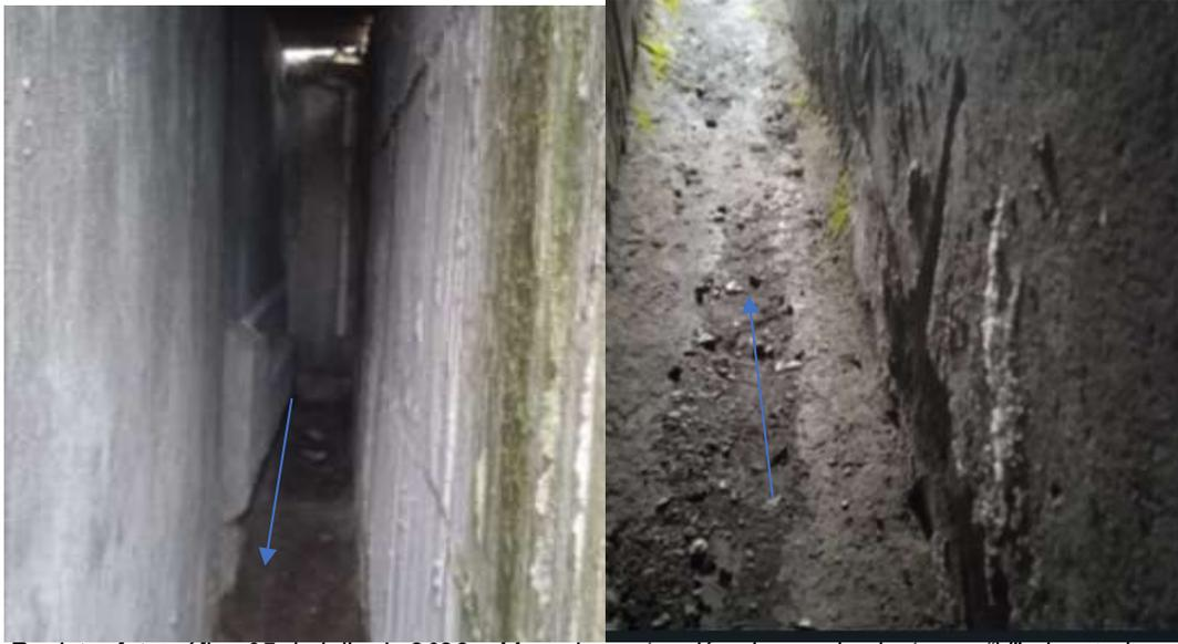
Registro fotográfico 05 de julio de 2023 – Muro de contención sin canal colector en “V” ejecutado
