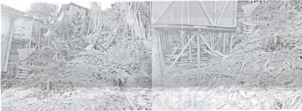
Imagen 1 y 2. Ladera afectada.
