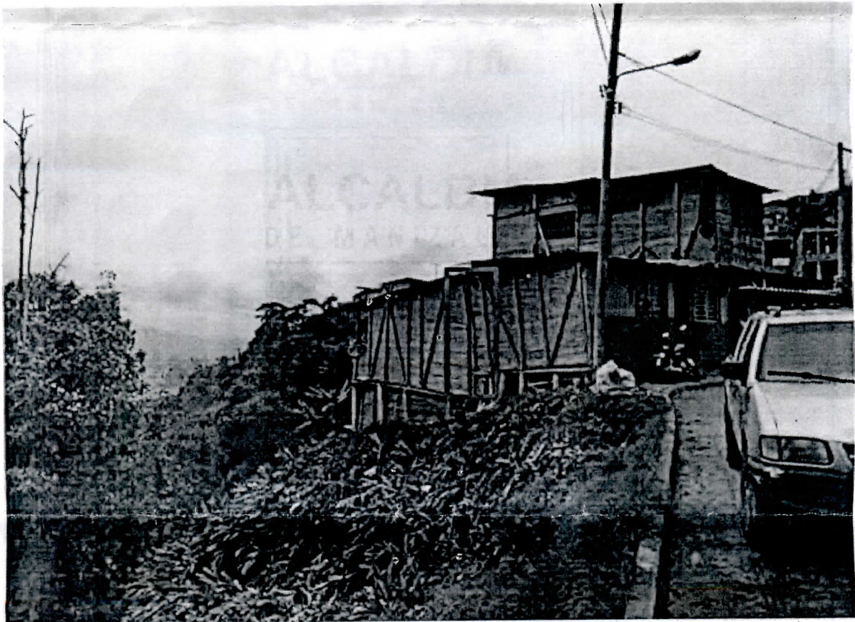
Imagen 2. Separación entre las dos paredes de esterilla, inclinación.
