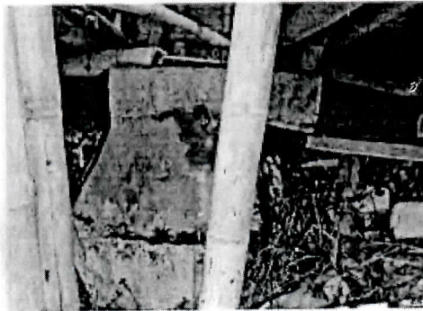
Imagen 5. Apoyo vivienda recamara, presenta filtraciones.
