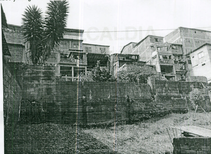
Imagen 2. Muro en mampostería no confinada en riesgo.
