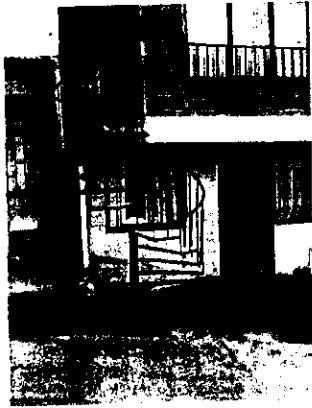
Foto No.7 Escaleras sobre zona verde.
