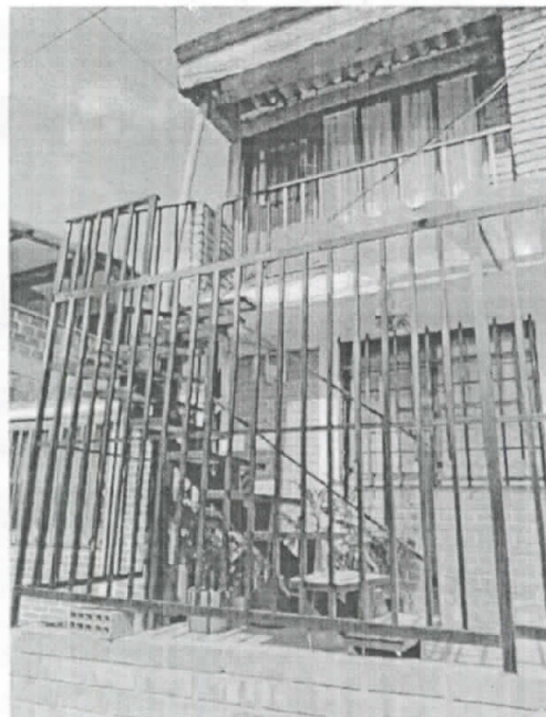
Foto No2. Escaleras construidas sobre zona verde.
