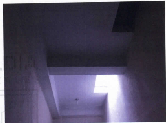
Foto No 28. Impermeabilización y pintura de cielo raso de baños
