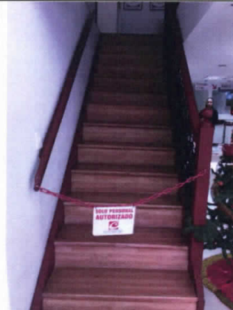
Foto No 14. Claro Telefonía. Escaleras en buen estado.
