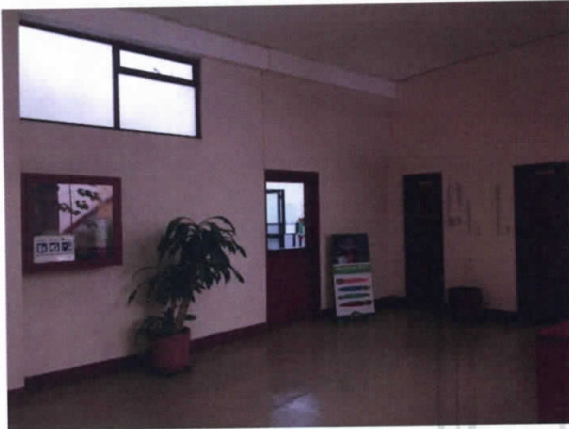
Foto No 27. Muros, puertas y pisos en buen estado.
