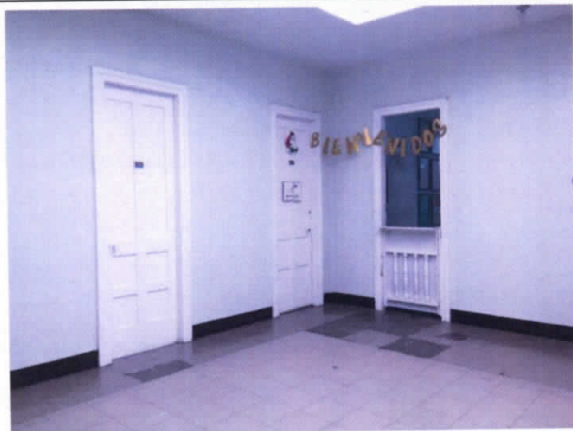
Foto No 29. Pisos, muros y puertas en buen estado.
