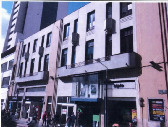
Foto No 1. Fachadas en buen estado.
