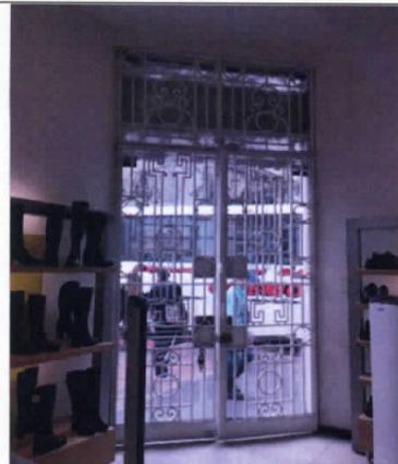
Foto No 10. Calzado Alpie. Puerta de acceso en buen estado.
