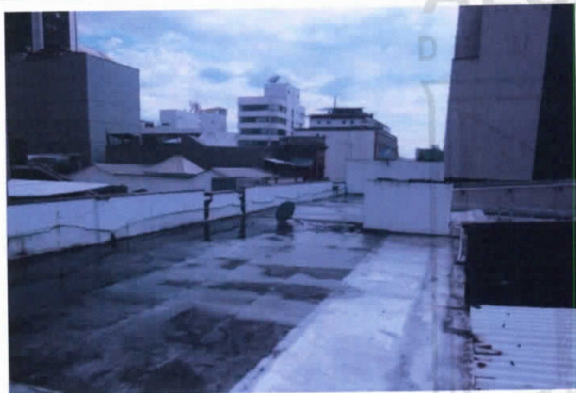
Foto No. 35. Muros de antepecho recién pintados.
