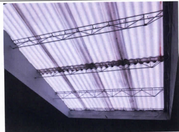
Foto No 30. Teja traslucida en buen estado.
