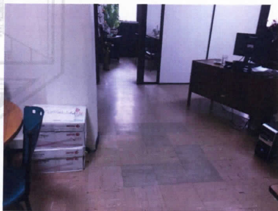
Foto No 24. Pisos en buen estado.
