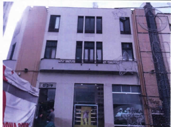
Foto No 2. Fachada en buen estado.
