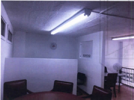
Foto No 13. Claro Telefonía. Muros y cielo raso en buen estado.
