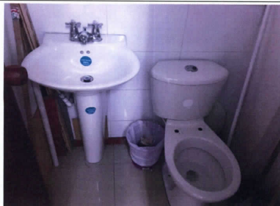
Foto No 16. Claro Telefonía. Baño en buen estado.
