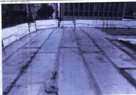
Foto No. 36. Losa impermeabilizada en buen estado.
