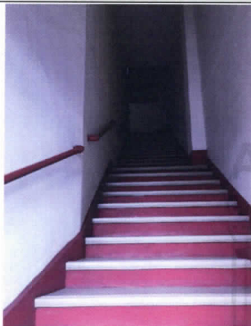
Foto No 21. Escaleras de acceso en buen estado.
