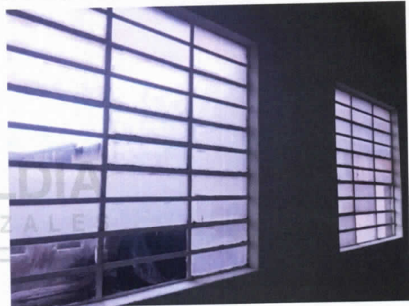
Foto No 32. Ventanas en buen estado.
