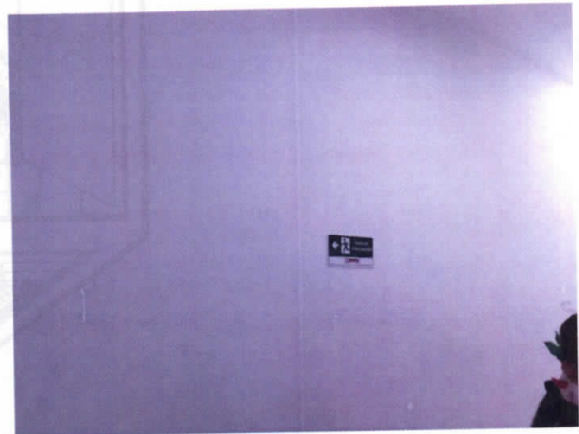
Foto No 10. Muros en buen estado. "ORTOTAL"
