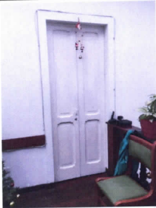
Foto No 29. Puertas en buen estado.
