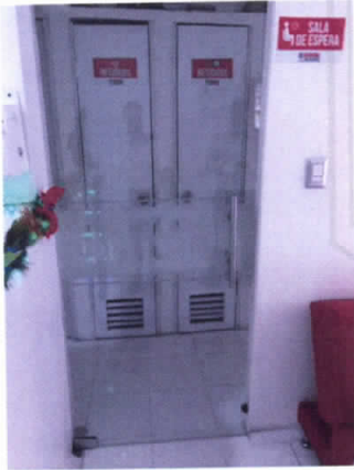
Foto No 21. Puertas en buen estado. "ORTOTAL".
