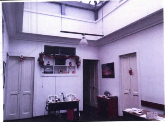
Foto No 26. Muros en buen estado.
