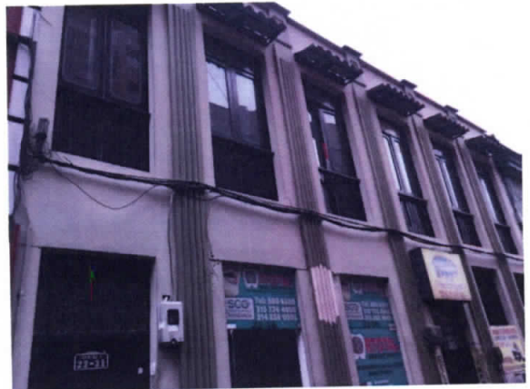
Foto No 2. Ventana en buen estado.
