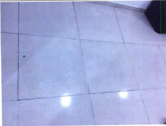
Foto No 17. Pisos en buen estado. "Bayport".
