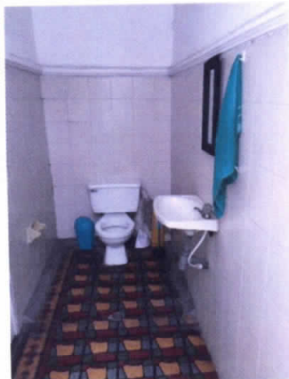
Foto No 39. Baño en buen estado.
