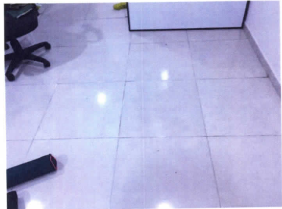
Foto No 18. Pisos en buen estado. "Bayport".
