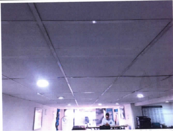
Foto No 13 Cielo raso en buen estado. "Bayport".
