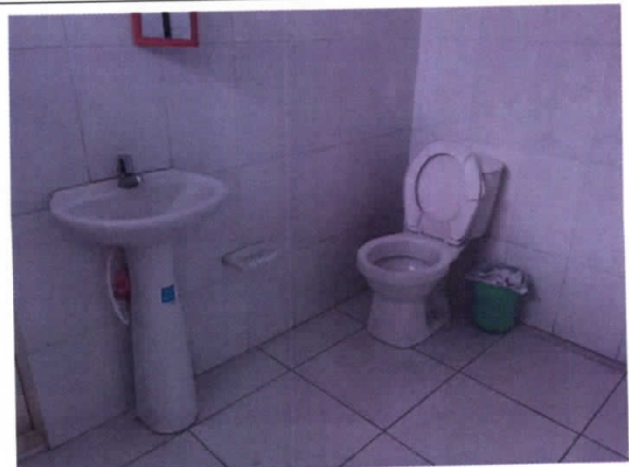
Foto No 40. Baño en buen estado.
