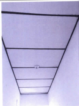
Foto No 31. Cielo raso en buen estado.
