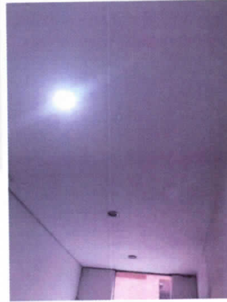
Foto No 16. Cielo raso en buen estado "ORTOTAL"
