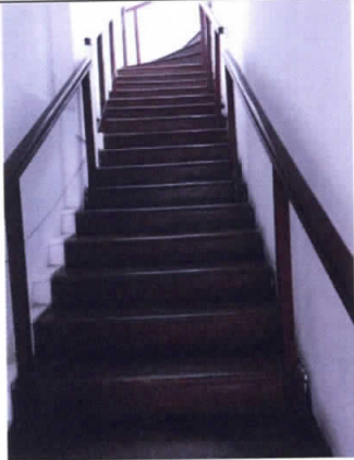
Foto No 25. Pisos en buen estado.
