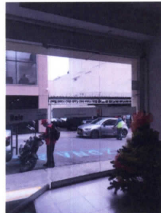
Foto No. 14, Puertas "Centro Visual Moderno" en buen estado.
