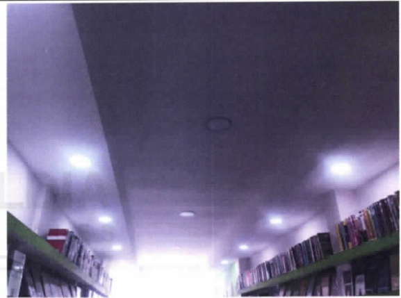
Foto No. 12, Cielo raso "LEYER Librería" en buen estado.
