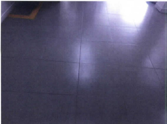
Foto No. 9, Pisos "Centro Visual Moderno" en buen estado.
