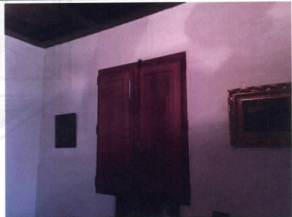
Foto No. 18, Muros y ventanas en Nivel 2 en buen estado.
