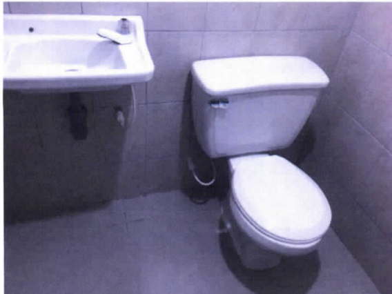
Foto No. 15, Unidad sanitaria "Centro Visual Moderno" en buen estado.
