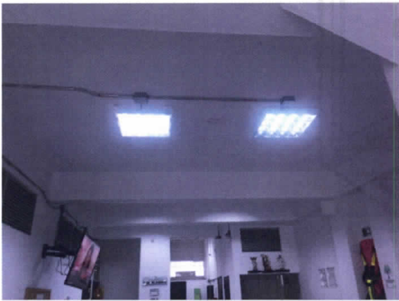
Foto No. 13, Cielo raso "Centro Visual Moderno" en buen estado.
