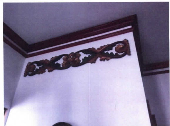
Foto No. 20, Muros Nivel 2 en buen estado.
