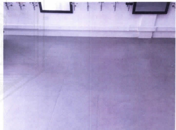
Foto No. 8, Pisos "Centro Visual Moderno" en buen estado.
