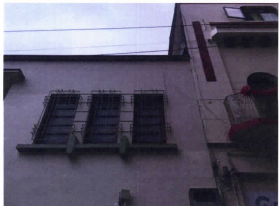
Foto No. 2, Muros y ventanas en buen estado.
