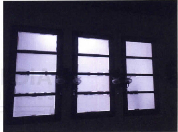
Foto No. 28, Ventanas Nivel 2 en buen estado.
