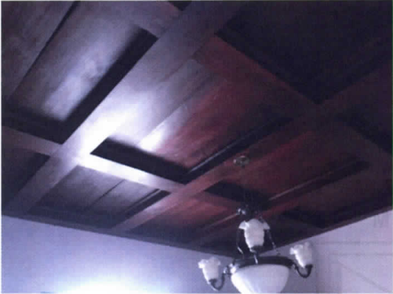
Foto No. 27, Cielo raso Nivel 2 en buen estado.
