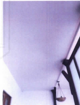
Foto No. 24, Cielo raso Nivel 2 en buen estado.
