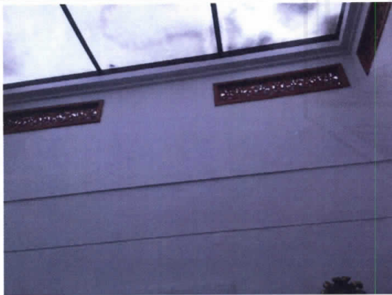
Foto No. 17, Muros en Nivel 2 en buen estado.
