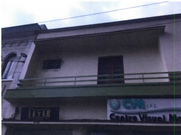
Foto No. 1, Muros y ventanas en buen estado.
