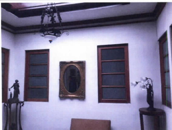
Foto No. 19, Muros Nivel 2 en buen estado.
