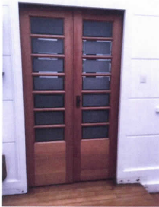
Foto No. 29, Puertas Nivel 2 en buen estado.
