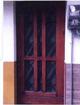
Foto No. 30, Puertas Nivel 2 en buen estado.
