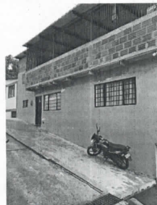
Foto No.4 Estado actual del predio ubicado en la Calle 48J No.8C-68
