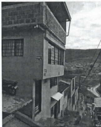
Foto No.3 Estado actual del predio ubicado en la Calle 48J No.8C-68.
