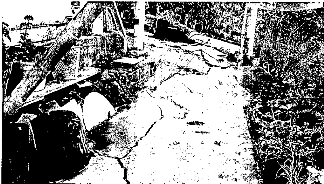
Imagen 1. Agrietamiento en losa de concreto – Patio de vivienda.
