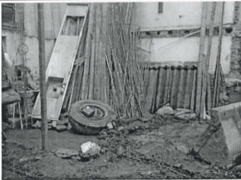
Foto No. 1 Demolición del inmueble sin licencia aprobada
