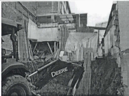
Foto No. 3 Excavaciones sin licencia aprobada
