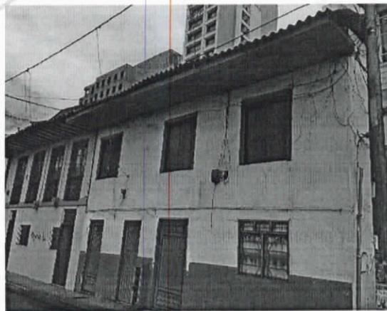
Foto No.2 Fisura en alero, costado izquierdo del inmueble.
