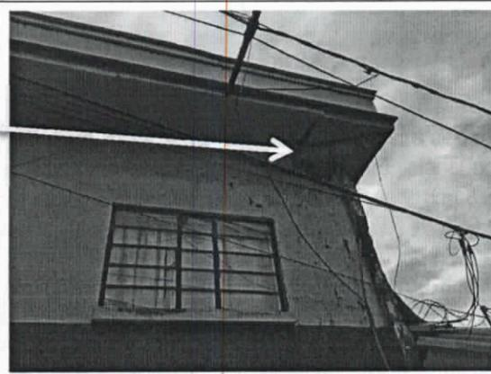
Foto No.2 Parte izquierda del alero en mal estado.
