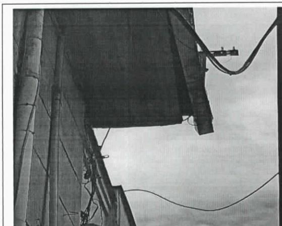
Foto No.3 Desprendimiento de la canal ubicado en el alero.
