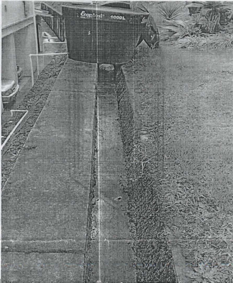
Imagen 2. Zanjas colectoras en buen estado
