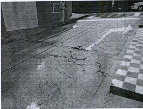
Área de pavimento afectado: 30M2 aproximadamente
