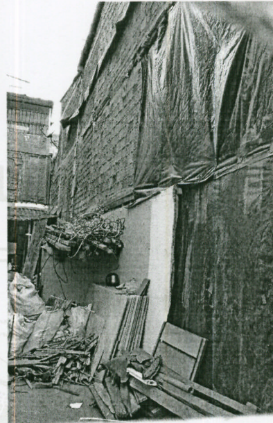
Paredes cubiertas por plástico
