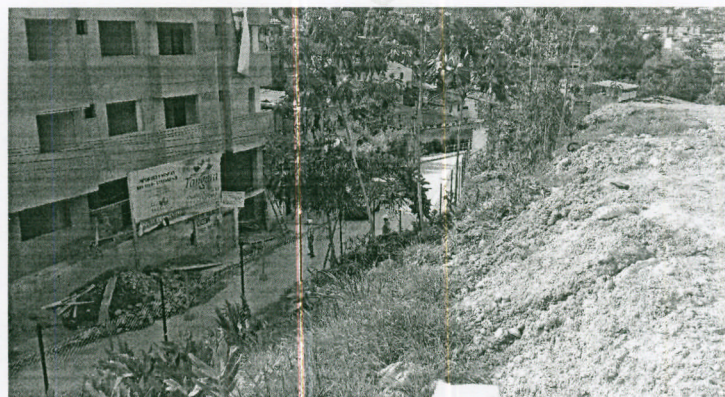
Material acumulado tras la intervención
