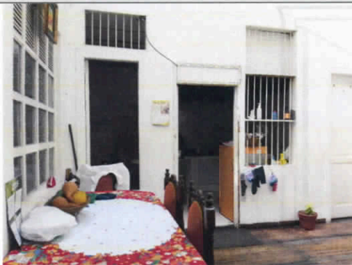
Fotografía 7. Piso en balsa de cemento en buen estado
