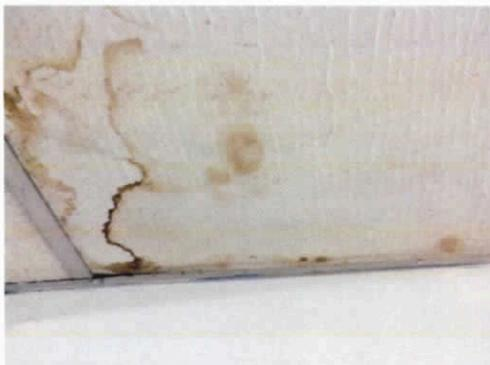
*Fotografía 7. Cielo raso en con láminas deterioradas*
