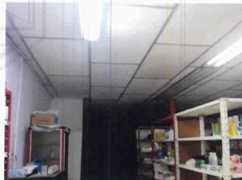
Fotografía 10. Cielo raso en lámina en poliestireno
