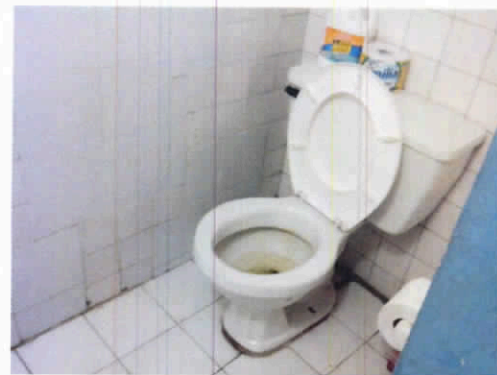
Fotografía 12. Baños en buen estado
