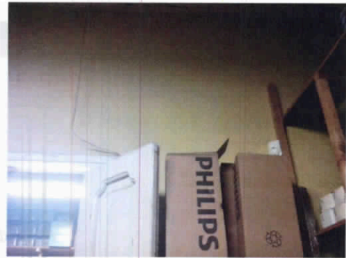
Fotografía 28. Fisuras en Muros
