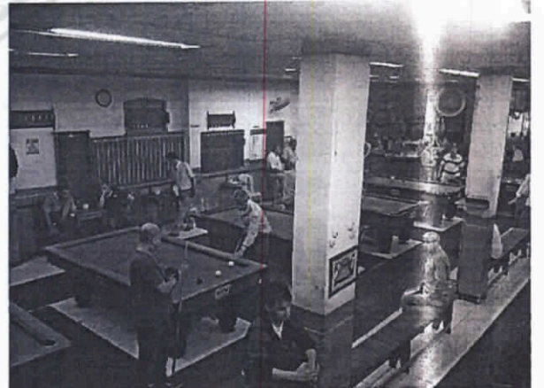
PISO EN MAL ESTADO Y PINTURA EN REGULAR ESTADO. LOCAL ACADEMIA DE BILLARES Y FUENTE DE SODA MANHATTAN.
