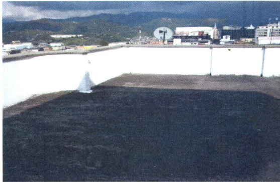
FOTO No.9 TERRAZA - CUBIERTA EN BUEN ESTADO
