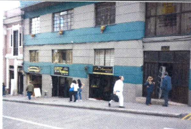
FOTO No. 1 LOCALES CARRERA 21
