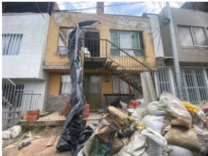
Foto No 1. Fachada principal del predio, escombros sobre el área del antejardín y acceso al segundo nivel del inmueble por medio de escaleras metálicas localizadas en el antejardín.
