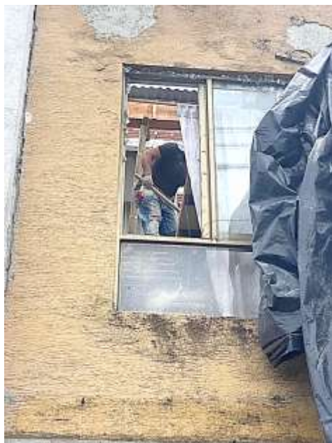
Foto No 2. Personal realizando labores constructivas.
