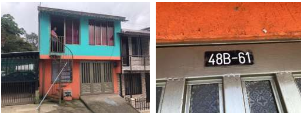
Foto No 1 y 2. Fachada principal del predio y nomenclatura
