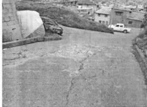
Área de pavimento afectado: 30M2 aproximadamente
