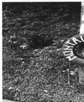
Caverna que se ha formado porque el dren tiene su salida muy profunda
