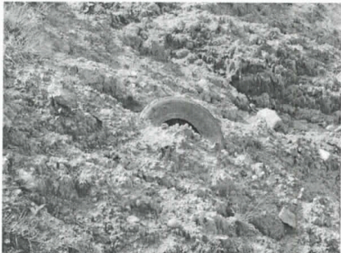
Foto No. 1 Escombros
