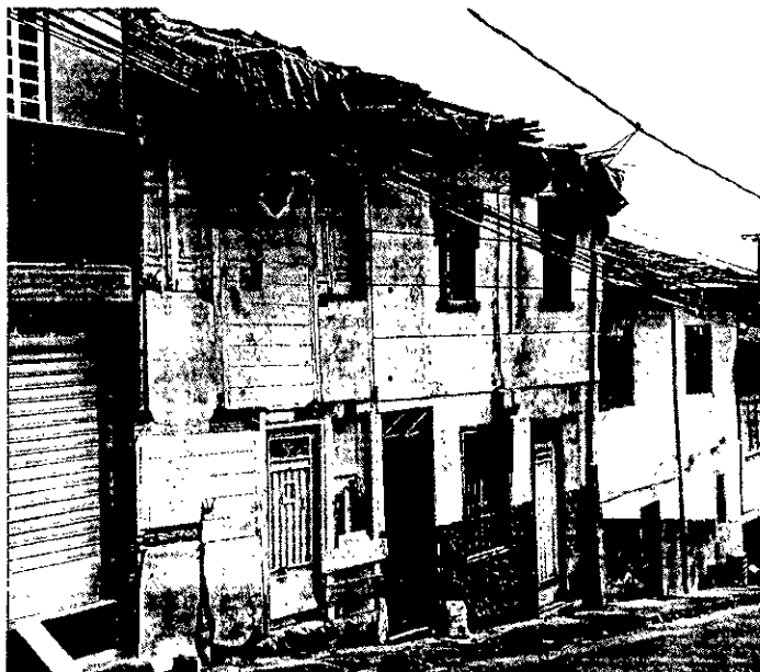
Imagen 2. Estado exterior de las viviendas.
