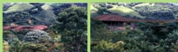
Foto 22 y 23. Registro Jesús Vélez Estrada. Año 1990 Se evidencia una construcción simétrica con los corredores perimetrales
