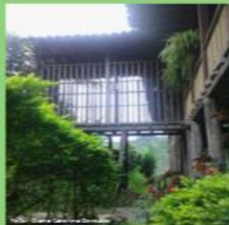
Foto 3.0: Detalle de corredor
