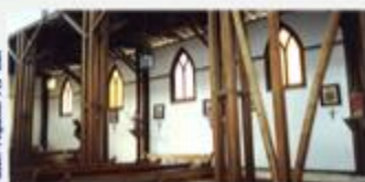
Deposición de la estructura a la vista
