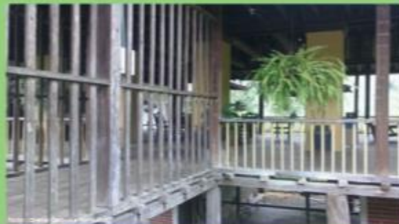
Foto 3.6: Estructura de acceso
