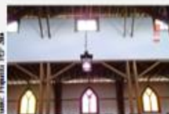
Sistema de iluminación
