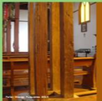
Foto 4.3: Detalle de estructura. Iglesia la Medalla Milagrosa
