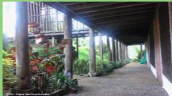
Foto 3.5: Detalle de corredor
