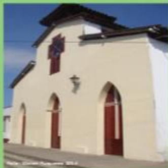
Foto 4.0: Fachada frontal. Iglesia la Medalla Milagrosa
