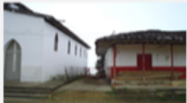
Estructura y mampostería
