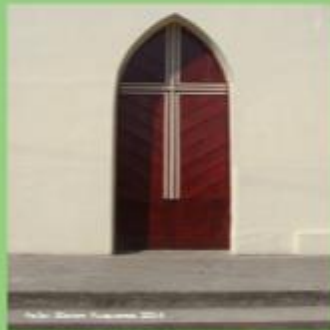
Foto 4.6: Detalle de la fachada frontal
