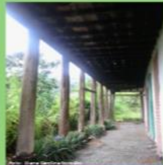
Foto 3.3: Pasillo primer piso
