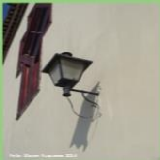
Foto 4.1: Detalle de la fachada frontal. Iglesia la Medalla Milagrosa
