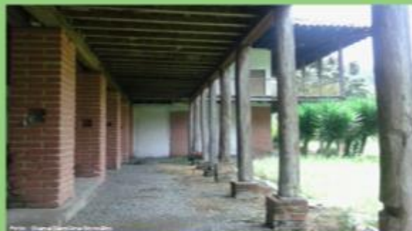
Foto 3.2: Pasillo primer piso
