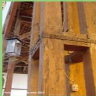
Foto 4.8: Detalle de estructura. Iglesia la Medalla Milagrosa
