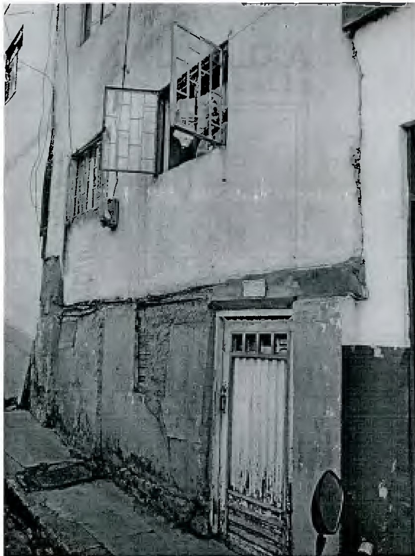
Imagen 3. Vista frontal de la vivienda.
